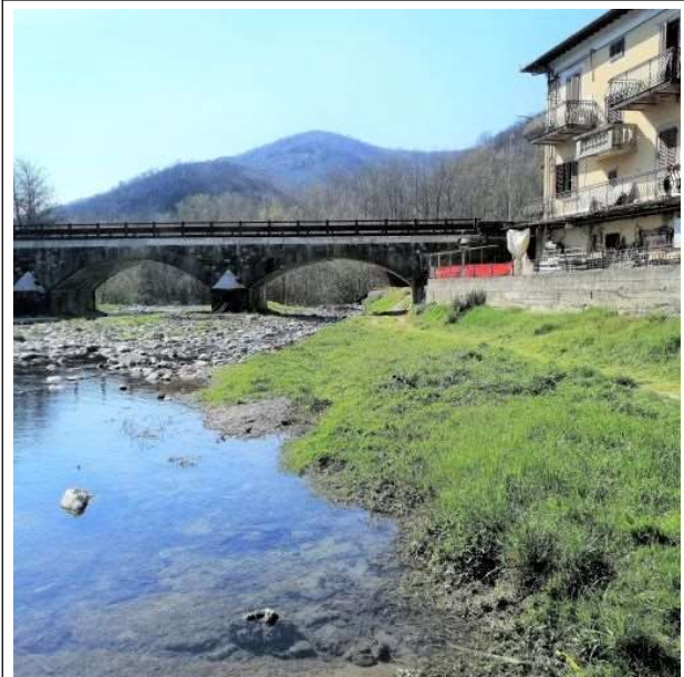
Il passaggio della ciclovía sotto al ponte stradale del torrente Moscia a Contea
